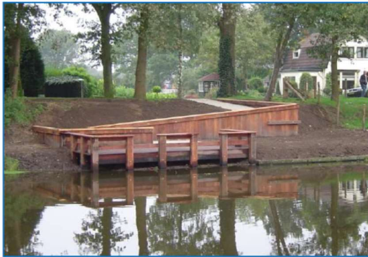
Foto: mindervalide steiger met dubbele helling
